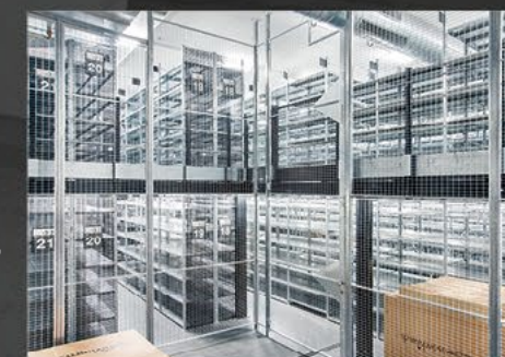
Gaswandscheiding van een etagevloer met legbordstellingen.
